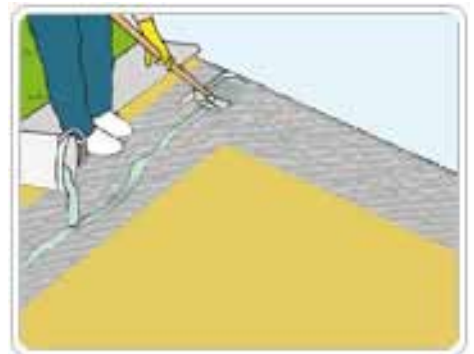
6 Aplicación de adhesivo
